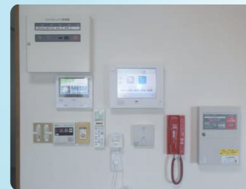
自動火災通報装置
