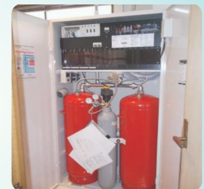
パッケージ型自動消火設備
