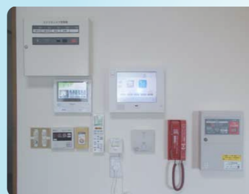
自動火災通報装置
