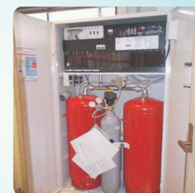
パッケージ型自動消火設備
