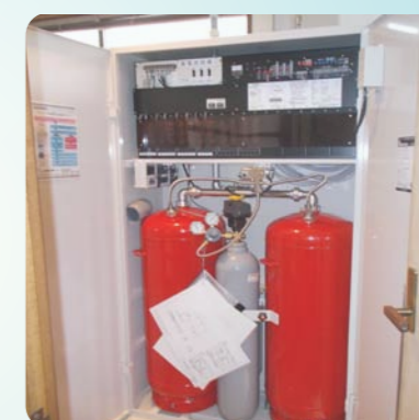
パッケージ型自動消火設備
