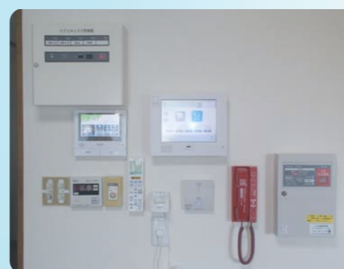
自動火災通報装置
